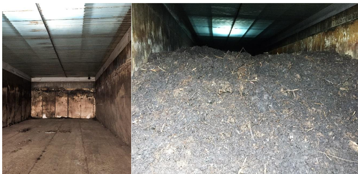
Obrázek 14 Vnitřek halové kompostárny – prázdná hala, naskladněný bioodpad do výše 3-4 m
