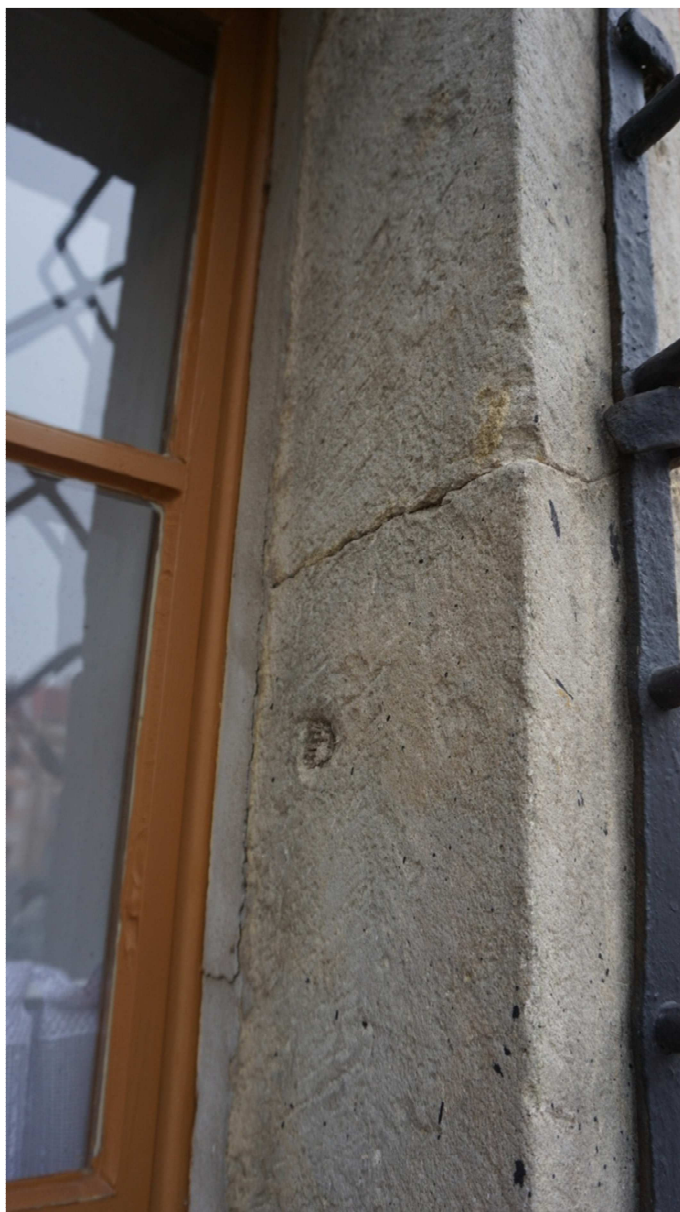
Detail poškození okenních ostění.
