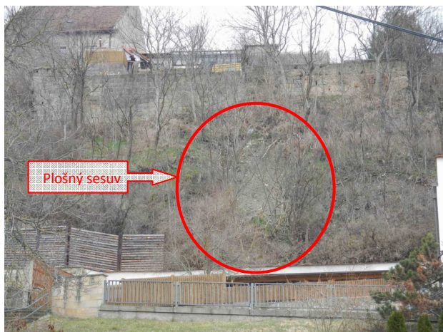
Mělký plošný sesuv nad domem čp.79: čelní pohled (vlevo) / pohled shora (vpravo)
