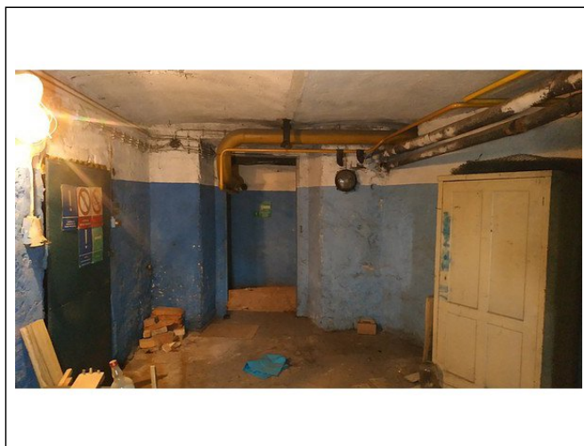
Suterén, sklep - Tyršův dům.
