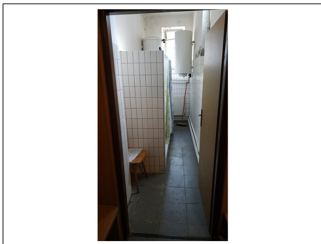
Umývárny - Tyršův dům.
