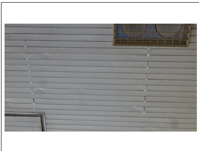
Nitovaný pohled haly nad hrací plochou.
