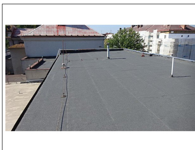
Pohled na střechu hotelu (1).
