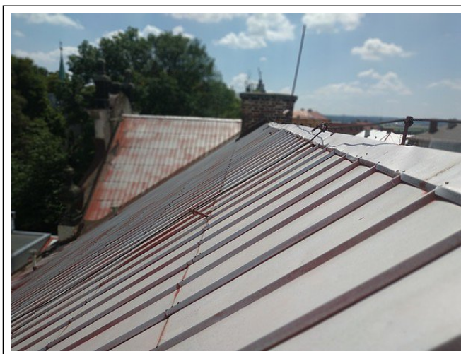
Pohled na střechu Tyršův dům.
