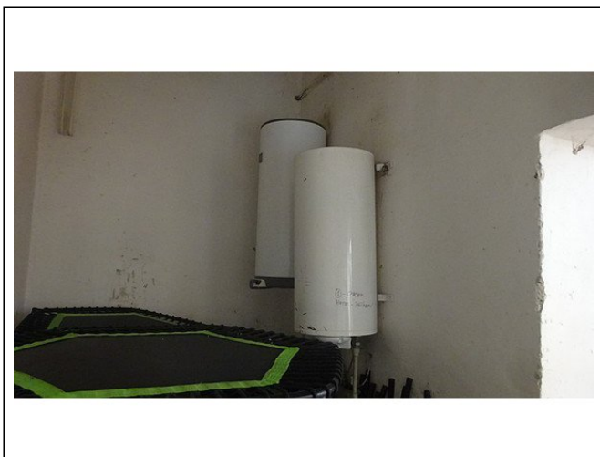
Příprava teplé vody (TUV) el. bojler.
