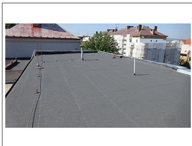
B) HOTEL - Pohled na střechu.
