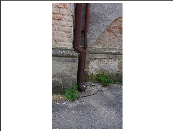
Okapový svod svedený na terén.
