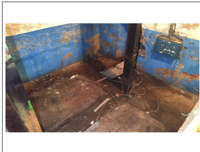
Masivní opadávání omítky, barvy vlivem vlhkosti.
