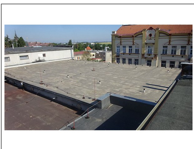
Pohled na střechu malé tělocvičny, ubytovny.
