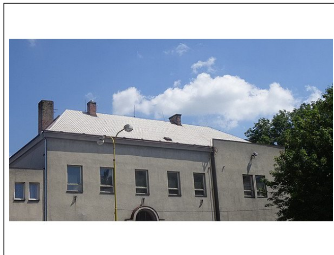
Pohled na střechu Tyršův dům z ulice Tyršovo náměstí.
