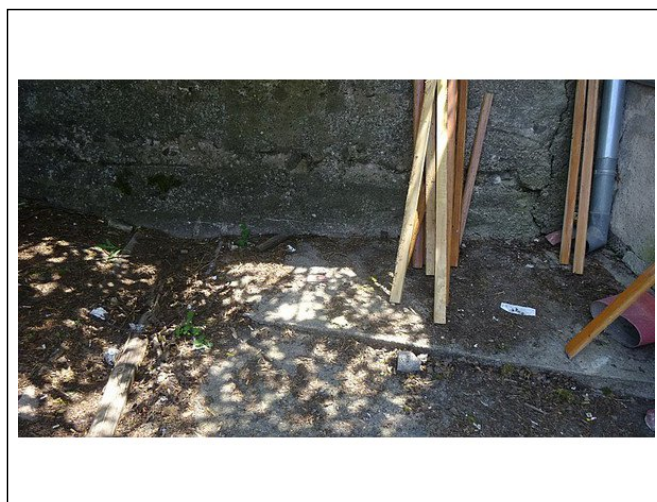
Okapový svod svedený na terén.
