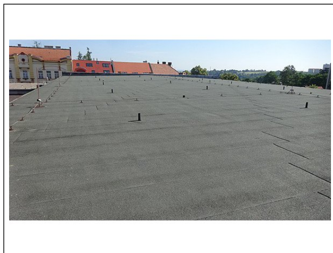
F) SPORTOVNÍ HALA - Pohled na střechu.
