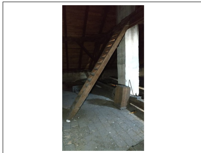
Dřevěné schodiště půda.
