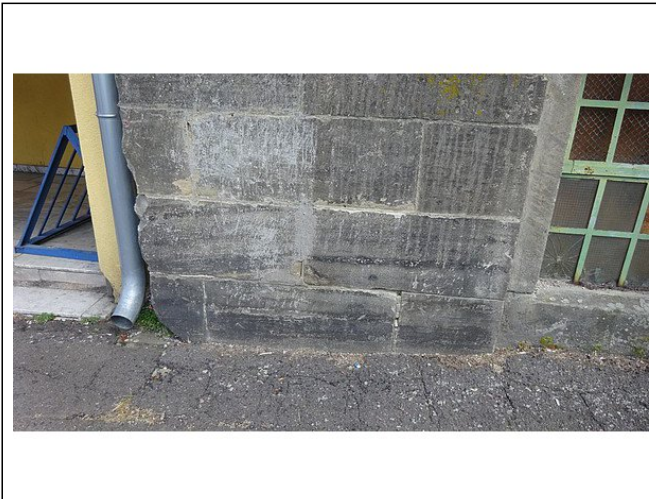
Okapový svod svedený na terén.
