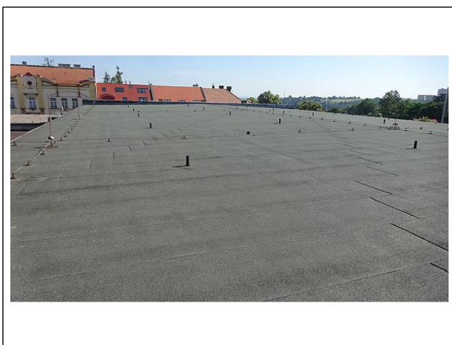
Pohled na střechu nad sportovní halou (4).
