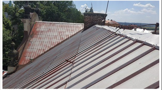
Pohled na plechovou falcovanou krytinu.
