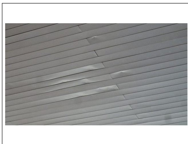
Nitovaný podhled haly nad hrací plochou.
