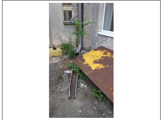
Okapový svod svedený na terén.
