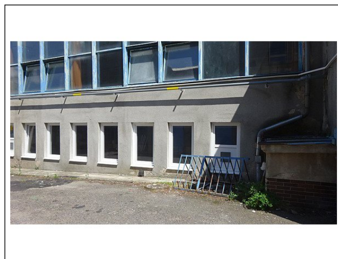
Pohled na řešenou stěnu sportovní haly ze dvora.
