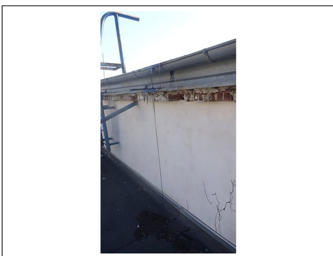
F) SPORTOVNÍ HALA - Odkapávající asfalt na vedlejší střechu.ozpuštěného asfaltu.
