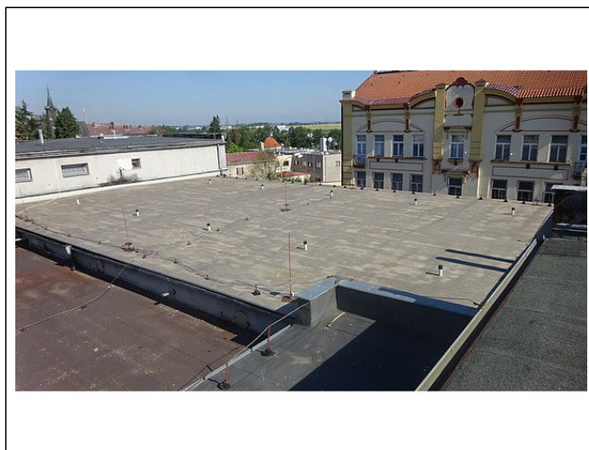
C) MALÁ TĚLOCVIČNA - Pohled na střechu.
