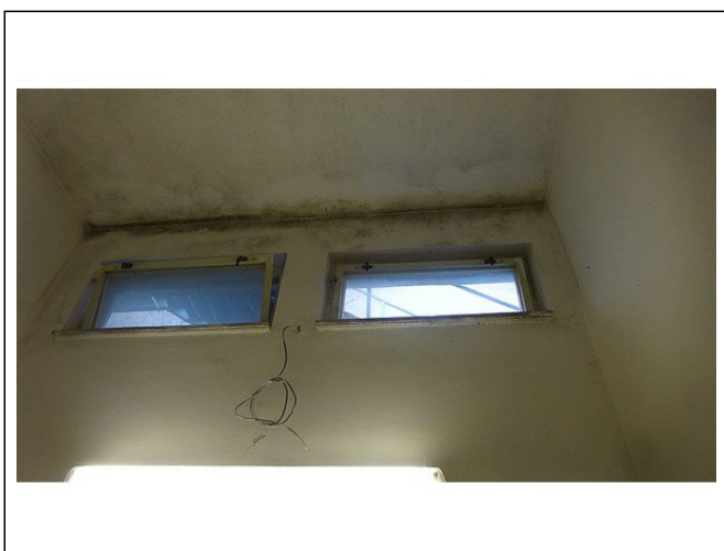
Umývárny u šaten sportovní haly - plísně v horních rozích a koutech.
