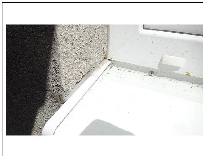
Nedostatečné zasazení plastového parapetu do ostění.
