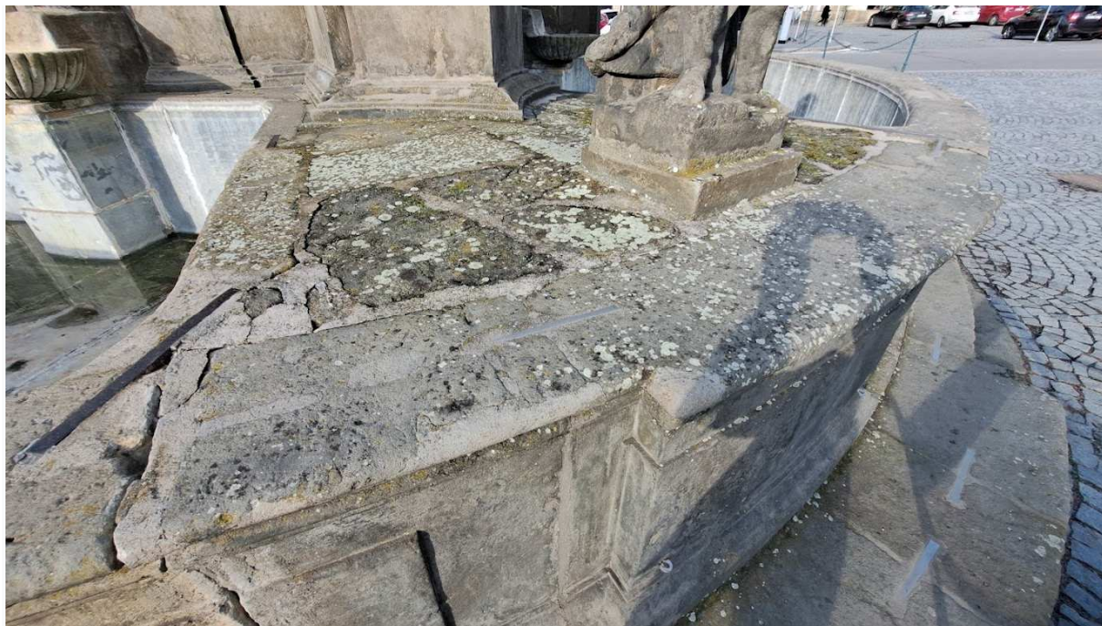
Detail poškození některých pískovcových desek. Plocha mezi kašnami označená pracovním pole B.
