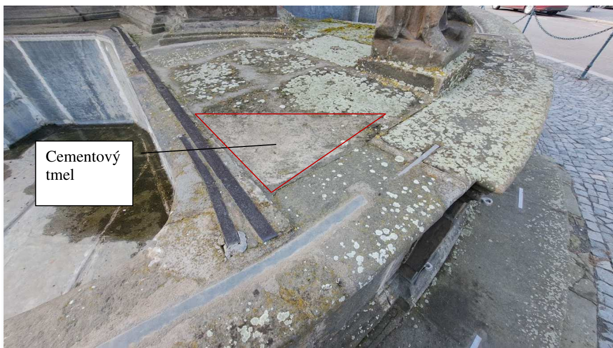
Detail poškození některých pískovcových desek. Plocha mezi kašnami označená pracovním pole C.
