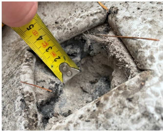
foto /2/ Tloušťka souvrství asfaltových pásů v sondě S1
