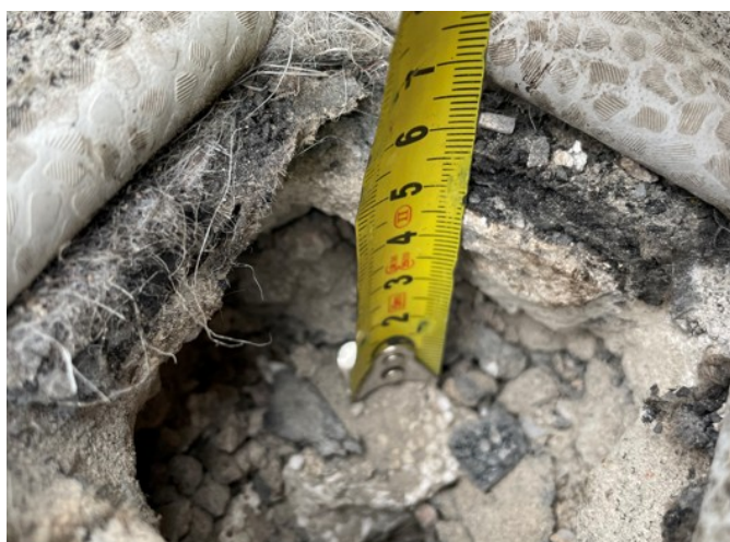
foto /4/ Tloušťka vyrovnávací betonové vrstvy v sondě S2
