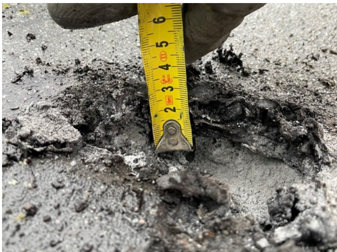
foto /9/ Tloušťka hydroizolačního souvrství v sondě S5
